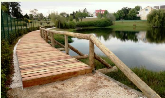
O setor de manutenção da Associação, está finalizando a reforma da ponte existente no Parque da Graciosa, a qual vinha apresentando riscos de segurança, em virtude do apodrecimento dos materiais. Grande parte da madeira utilizada nesta obra é reaproveitamento dos dormentes, substituídos por paver, por ocasião da reforma dos Parquinhos.
